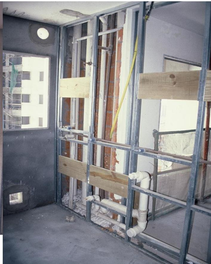
**“CONTRAPAREDE” EM CONTINUIDADE À PAREDE
