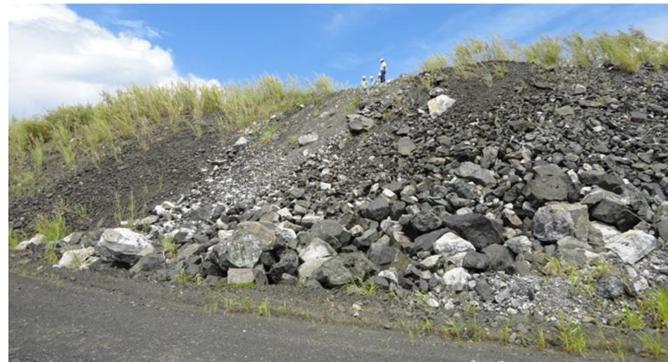
talude de uma pilha de bota-fora composta por material estéril
