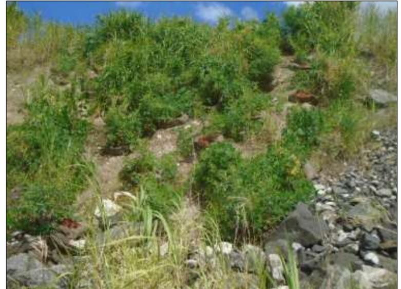
modelos de bioengenharia de solos para recuperar talude de bota-fora
