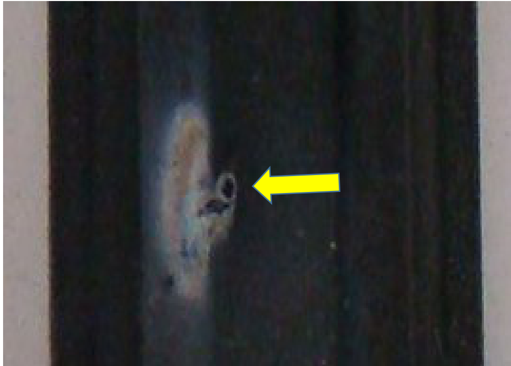
Detalhe da perfuração
