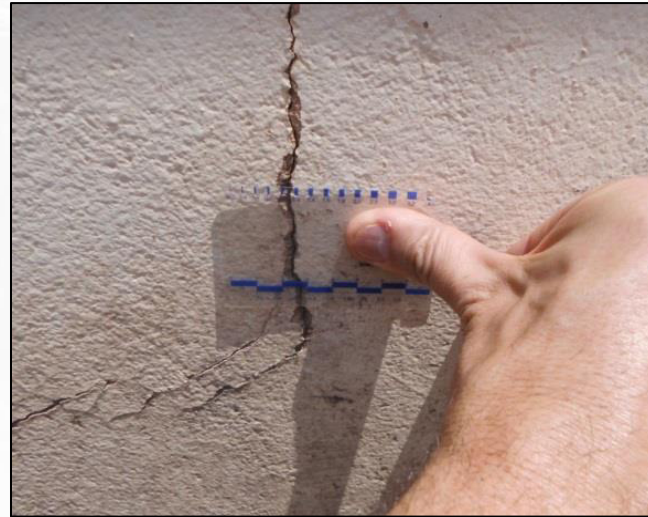
Configurações típicas de fissuras causadas por recalques de fundação
