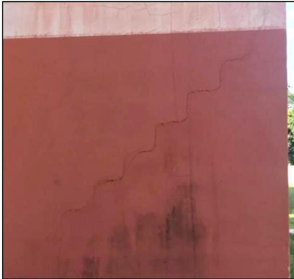
Configurações típicas de fissuras causadas por recalques de fundação
