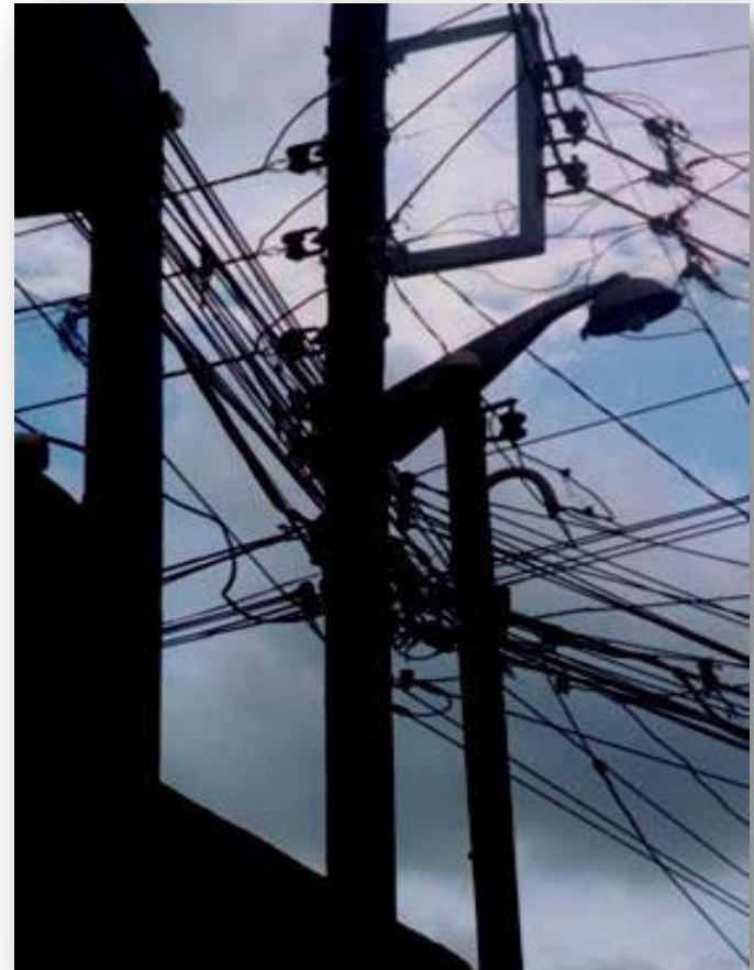
“Gatos” na rede elétrica
