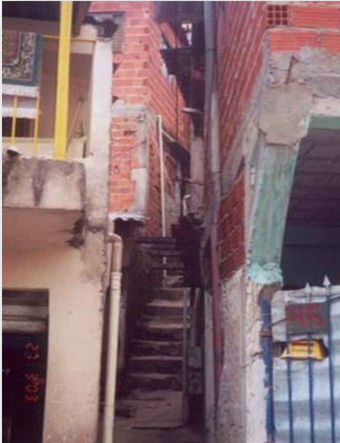
Rotas de fuga estreitas e de difícil acesso
