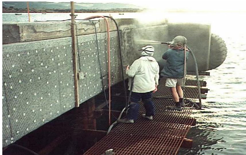
OBRA EXISTENTE- RECUPERAÇÃO: ANODO: Malha e fita de titânio (Ti/MMO) Zetacorr
