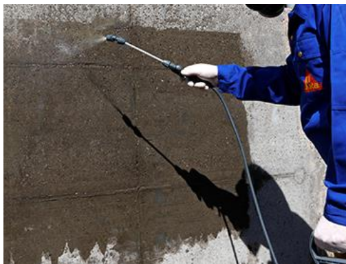
Adição na mistura fresca ou impregnação da superfície com inibidor de corrosão
