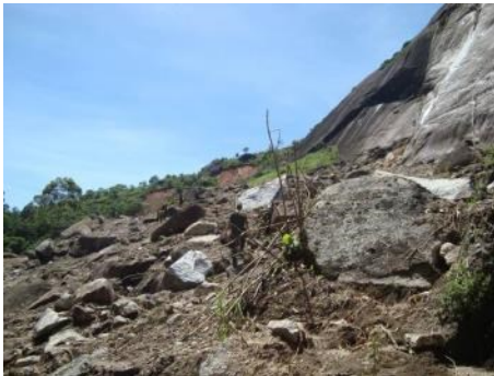
Queda de rocha ( rock fall )
