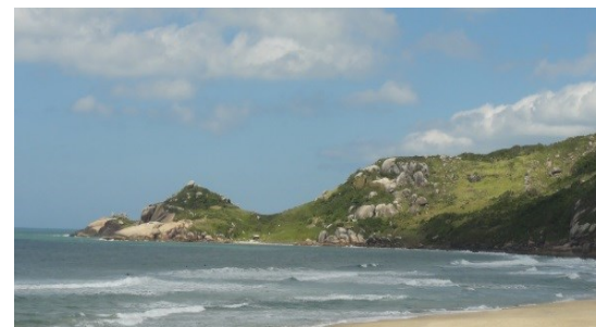
Figura 31 - Costão rochoso, com suscetibilidade localizada a quedas e deslocamentos de blocos rochosos - Florianópolis, SC.
