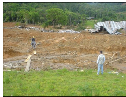
Geólogo observando os trabalhos de colocação de pranchas de madeira para criar acesso e caminho de fuga entre os pontos "quente" e o ponto de observação e controle, definindo-se claramente a rota de fuga (IPT)
