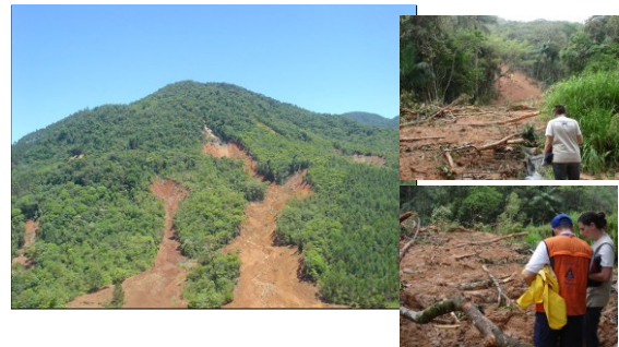
Vistoria dos trechos superiores das encostas. Sinais de instabilidade, degraus de abatimento e depósitos de material rompido a meia encosta (IPT)
