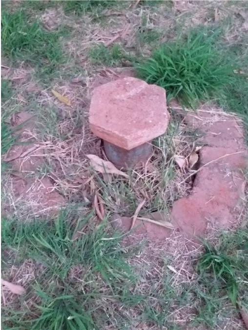
Poço abandonado, contando apenas com uma lajota como tampa e se encontra localizado a 21 m de poço em operação
