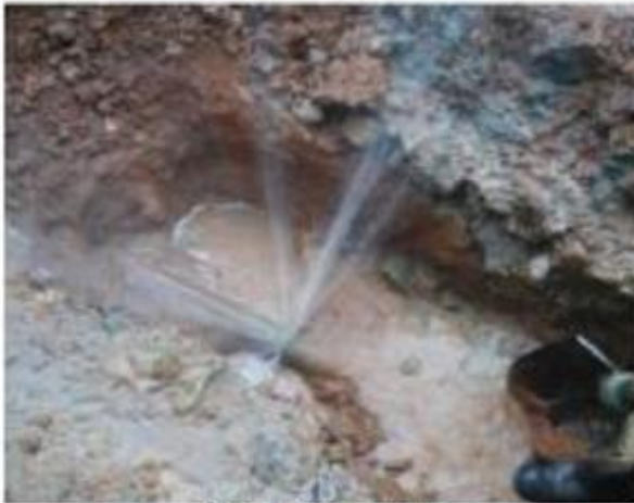
3 Local do Vazamento
