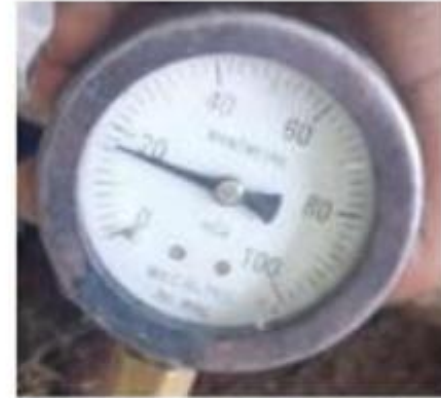
Pressão antes da troca (mca) = 17
