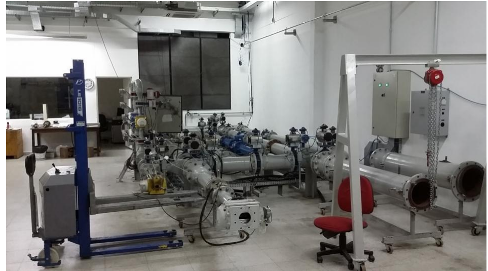
Laboratório de vazão de gás LV - TRM - IPT
