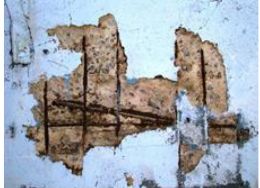
Armaduras expostas e corroídas dos estribos e bainha de protensão na região do encontro de ponte
