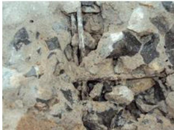
Vibração inadequada do concreto, proporcionando nichos de concretagem
