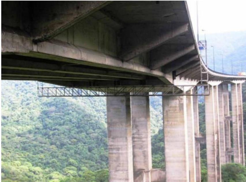
Plataforma metálica instalada sob o viaduto VA 19 da Rodovia dos Imigrantes em Cubatão – SP, utilizada pela Seção de Engenharia de Estruturas do IPT para os trabalhos de inspeção
