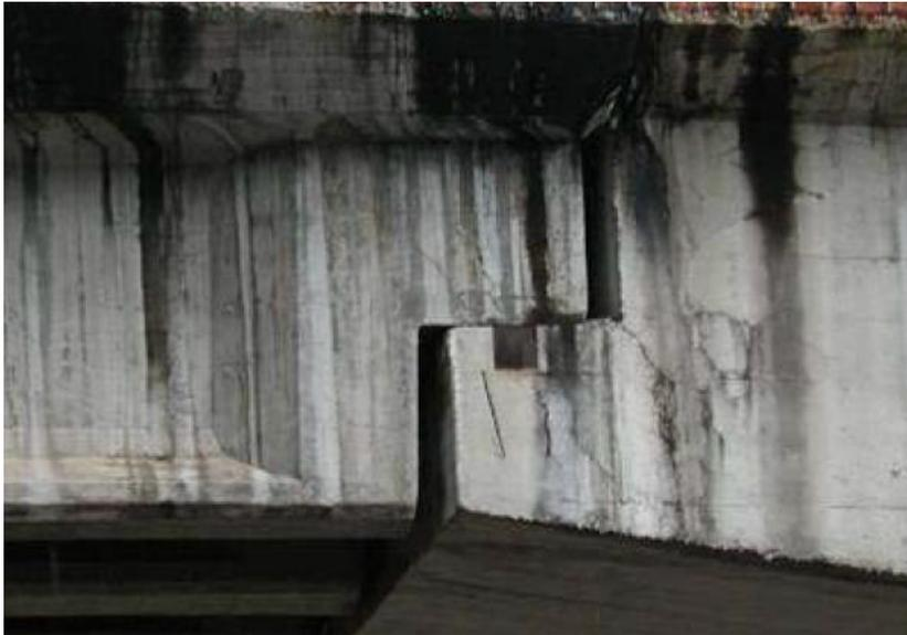
Fissuras inclinadas nos cantos da ligação Gerber
