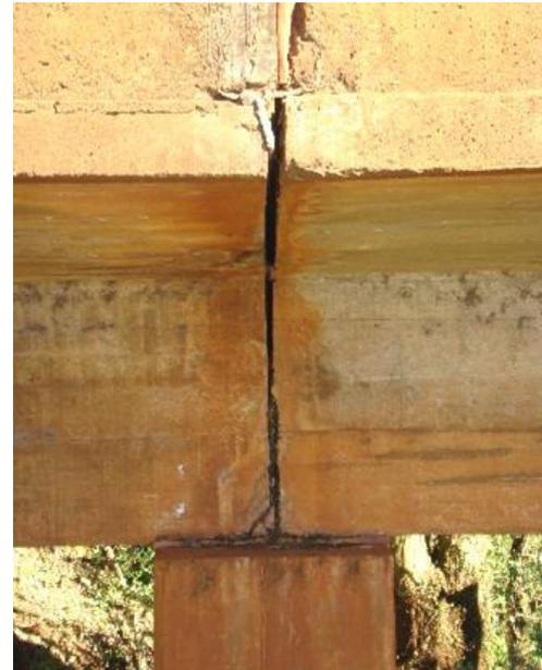
Fissuras no canto da viga, na região junto ao aparelho de apoio
