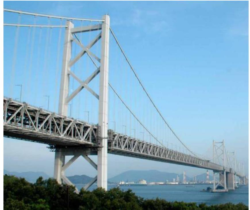
Ponte Minami Bisan-Seto - Ponte foi construída em 1988, com 1723 m de comprimento e vão central de aproximadamente 1100 m, destinada ao tráfego de veículos rodoviários e ferroviários.
