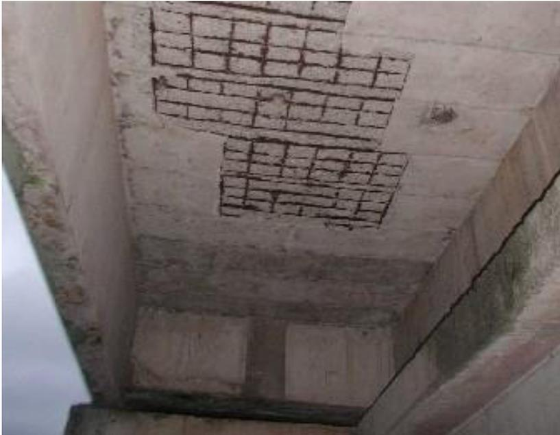
Cobrimento de concreto destacado e armaduras expostas e corroídas
