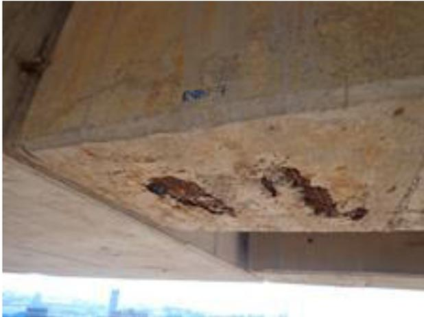
Falha de concretagem devido ao excesso de armaduras, não permitindo a passagem do concreto na região inferior de viga de ponte
