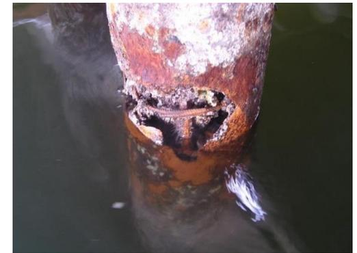
Estaca metálica preenchida com concreto armado – Note-se corrosão e ruptura no tubo metálico e a presença de falha de concretagem no interior do elemento estrutural
