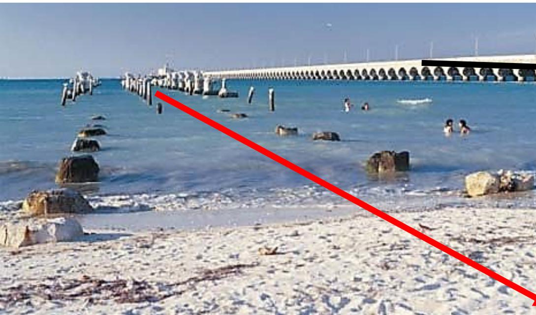
Pier de concreto, estrutura em barras de aço inoxidável
