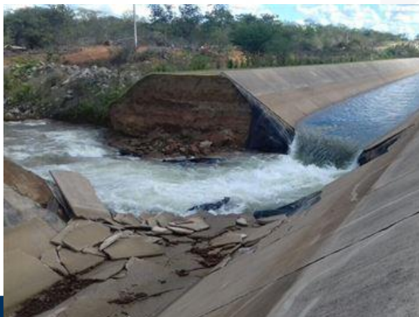
Rompimento provocou o vazamento no reservatório Barreiro, em Sertânia. Imagem: Reprodução/TV Cabo Branco
