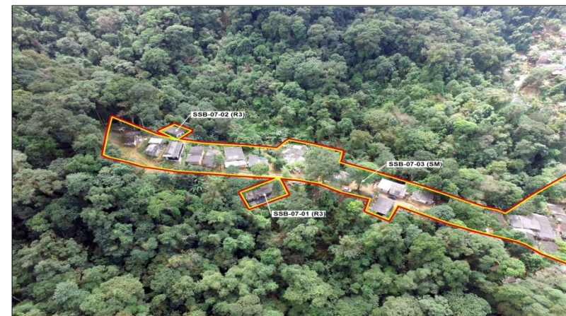
Figura 2 – Delimitação dos setores mapeados em foto oblíqua.
