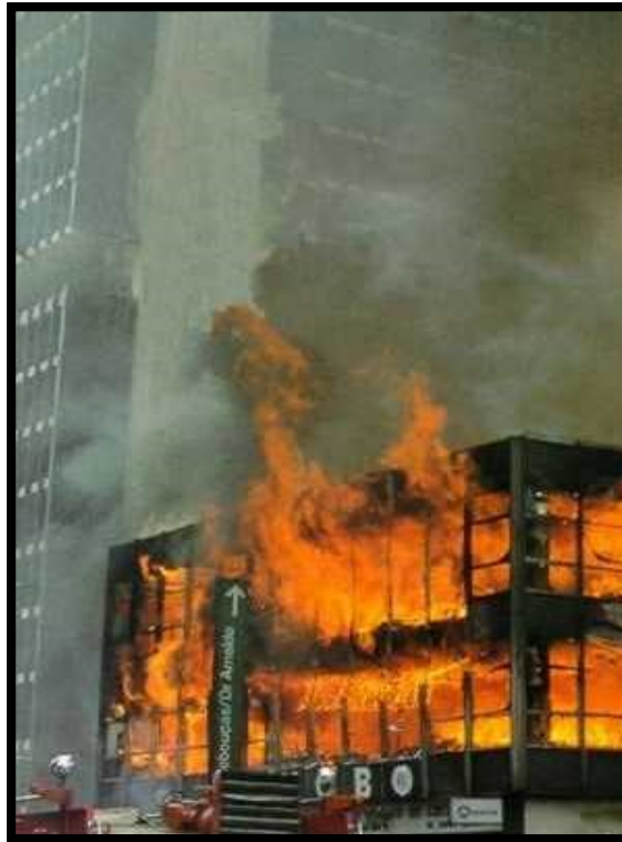
Pódio do edifício submetido a incêndio
