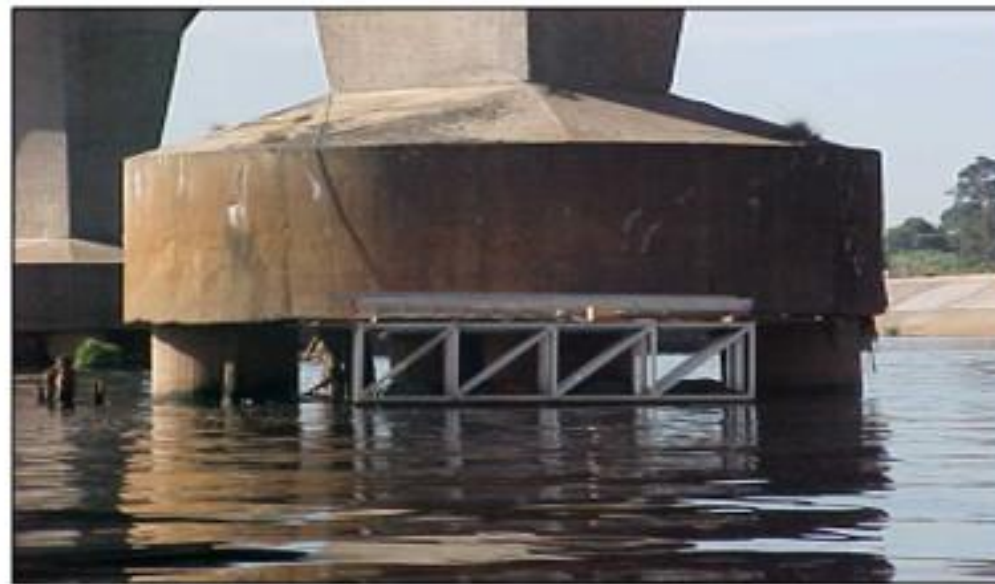
Montagem de plataforma flutuante para inspeção especial de elementos de fundação no Complexo do Cebolão, em São Paulo, SP.
