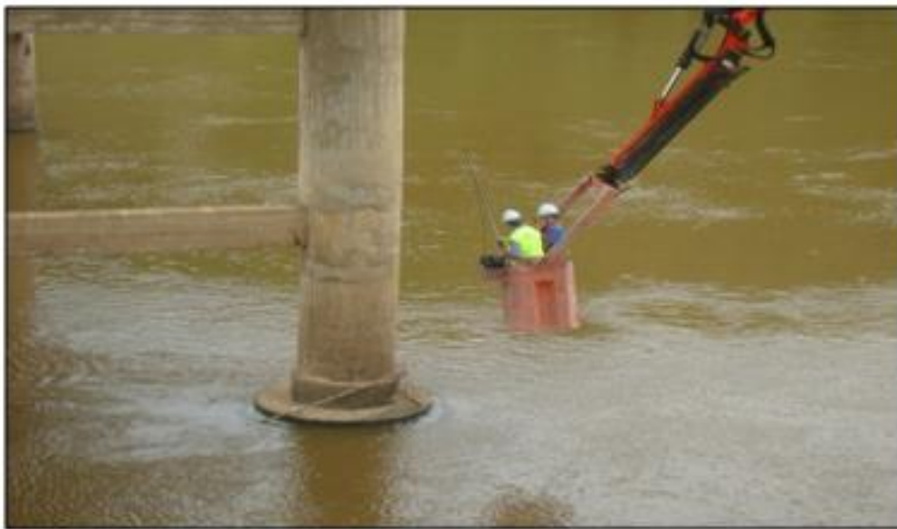
Inspeção especial da infraestrutura de uma ponte no município de Iporanga, SP, usando cestos.
