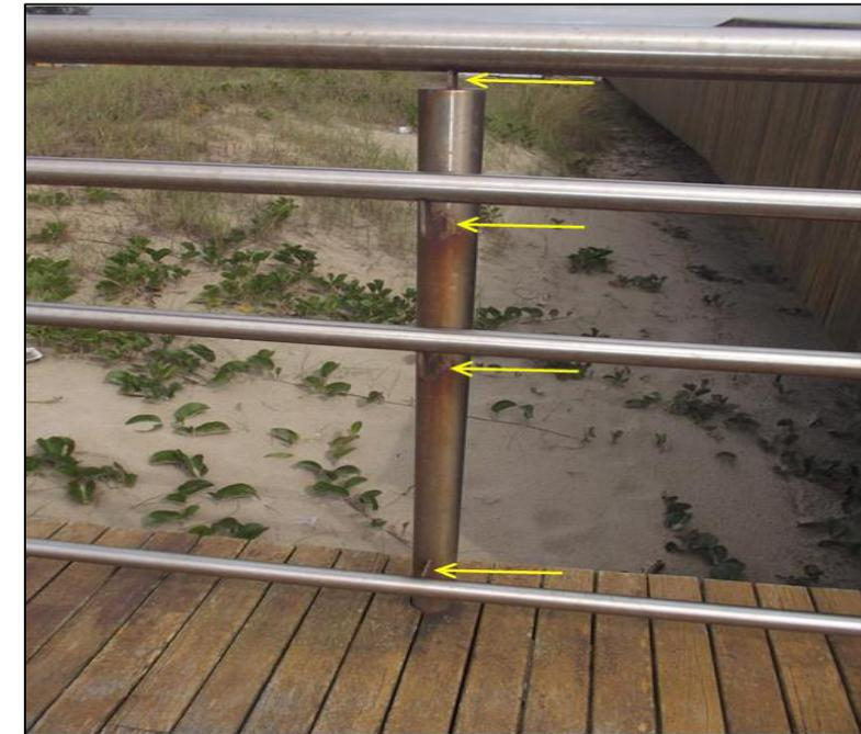
**Instalação de corrimão e montagem de coluna quiosque em região marítima misturando aço ferrítico com aços inoxidáveis austeníticos - Região: Litoral SP**
