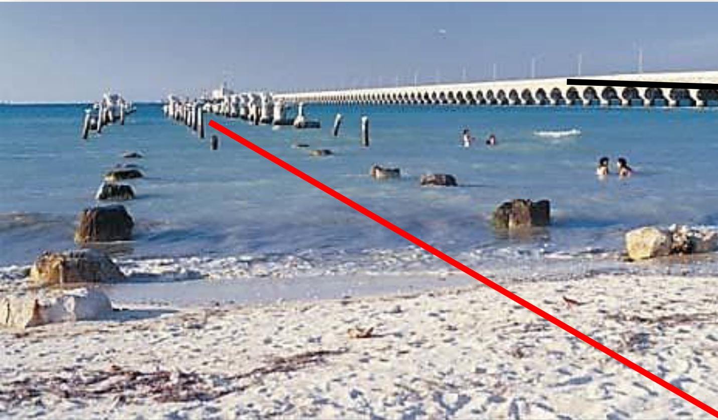
Pier de concreto, estrutura em barras de aço inoxidável (2 km + com 4,5 km = 6,5 km)
