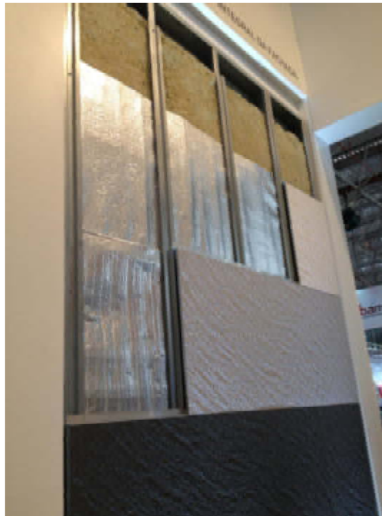
Fachada ventilada - placas poliméricas
