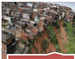
Condições de risco
