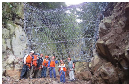
Instalação de Barreira Dinâmica
