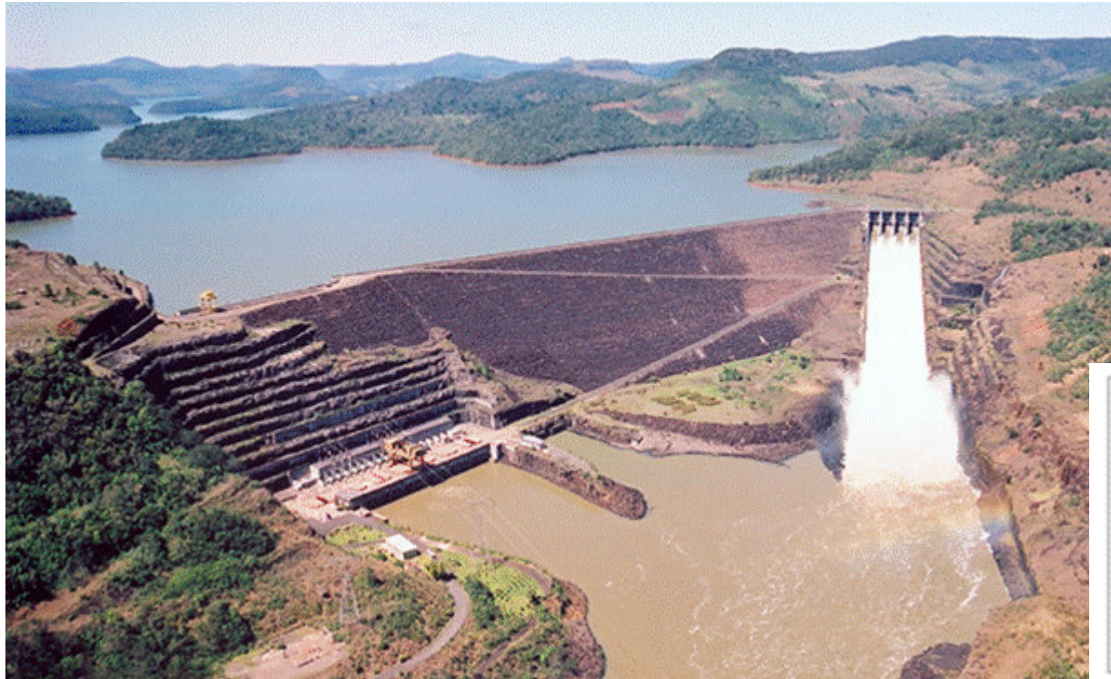
Barragem Foz do Areia
