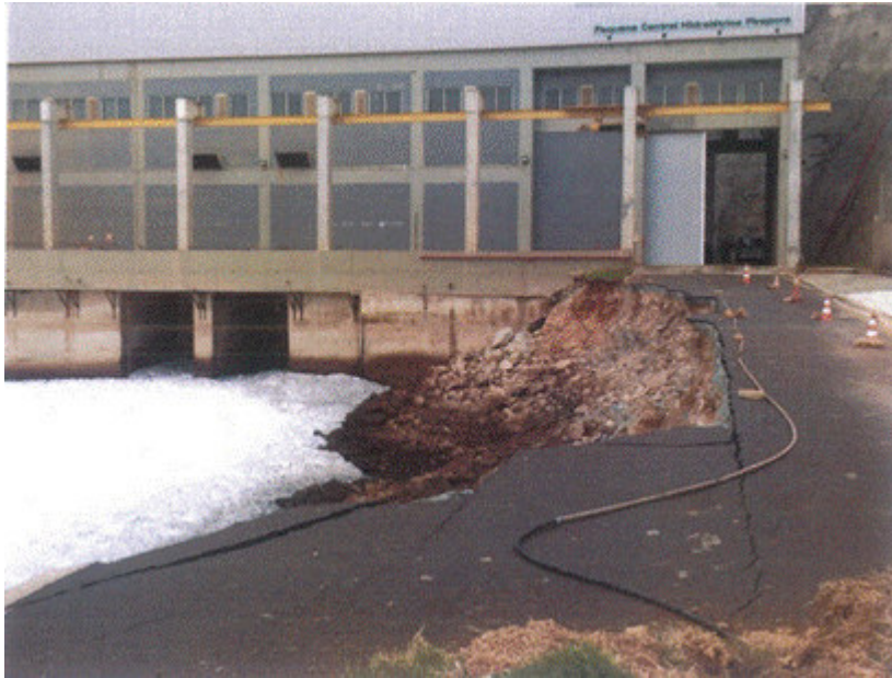
Barragem PCH de Pirapora
