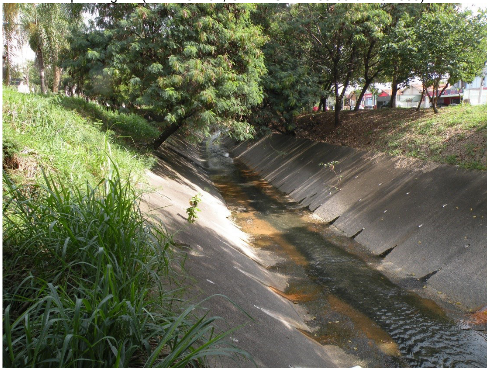
Figura 20 – Afluente do rio Capivari onde a planície aluvial foi urbanizada, com aterramento, canalização, arruamento e construção de casas, dificultando a delimitação e identificação pedológica. (Ponto CA-01, Coord. UTM: 289.032/7.462.865)
