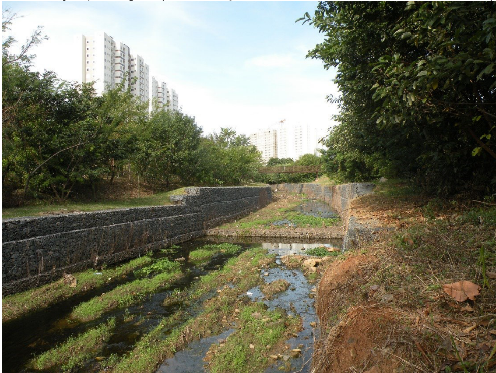
Figura 22 – Afluente do rio Capivari onde a planície aluvial foi urbanizada, com aterramento, canalização, arruamento e construção do parque linear, dificultando a delimitação e identificação pedológica. (Ponto Parque Linear, Coord. UTM: 286.406/7.464.092)
