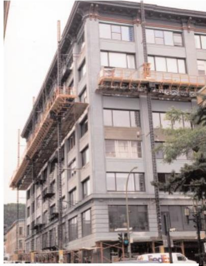
b) fachada apos operações de renovação
