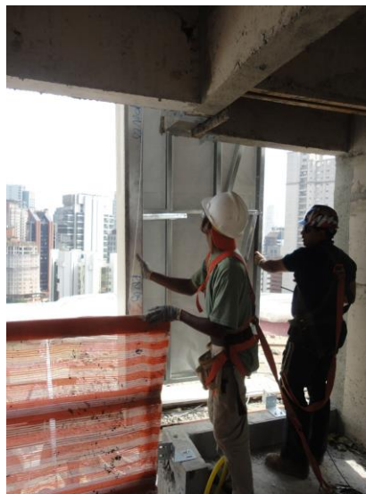
Interface da execução da fachada com os requisitos de segurança e saúde do trabalho
