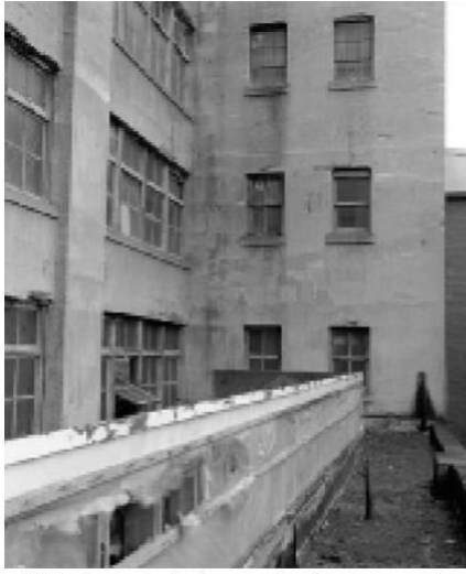
a) fachada em parede de concreto antes da renovação
