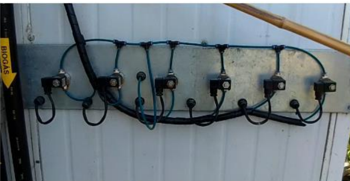
Válvulas solenoides direcionam o fluxo de biogás para o analisador
