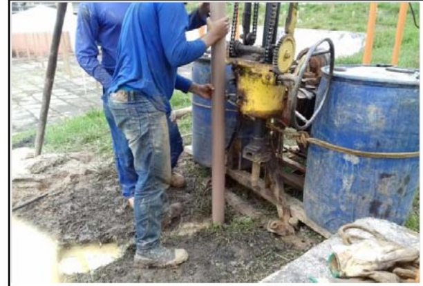
TUBO INSERIDO ATÉ PROFUNDIDADE DE 23,50 METROS
