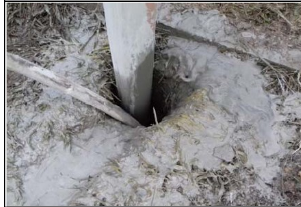
LANÇAMENTO DA CALDA DE CIMENTO
