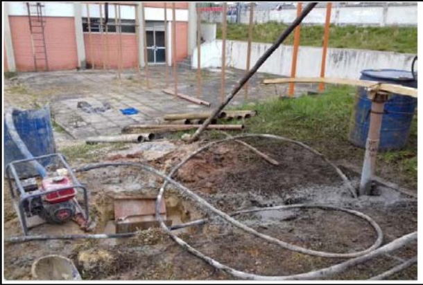
LANÇAMENTO DA CALDA DE CIMENTO
