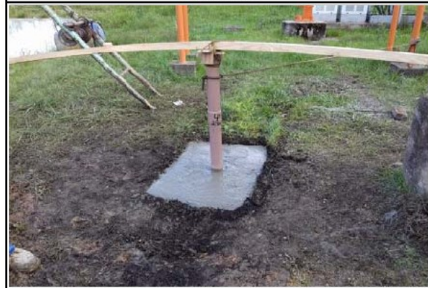
TUBO INSERIDO ATÉ PROFUNDIDADE DE 23,50 METROS
