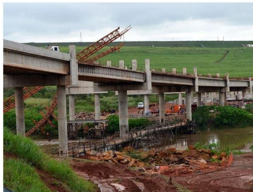
Acidente ocorreu nesta segunda-feira nas obras do novo anel viário de Piracicaba (Foto: Fernanda Zanetti/G1)
