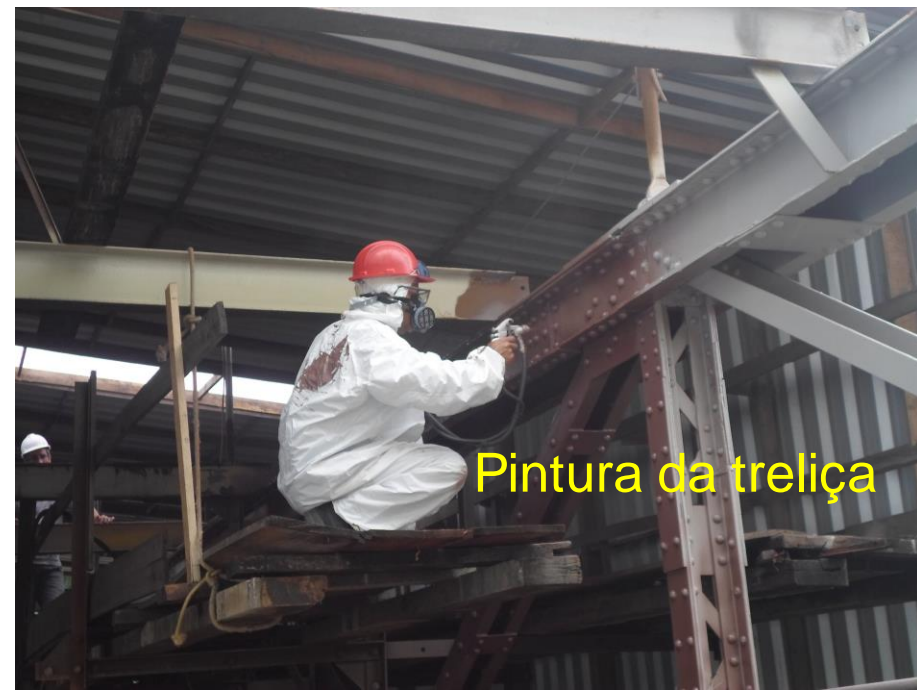
Recuperação de elemento metálicos Corroídos
