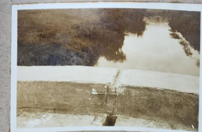
Tensometro instalado no fecho.
