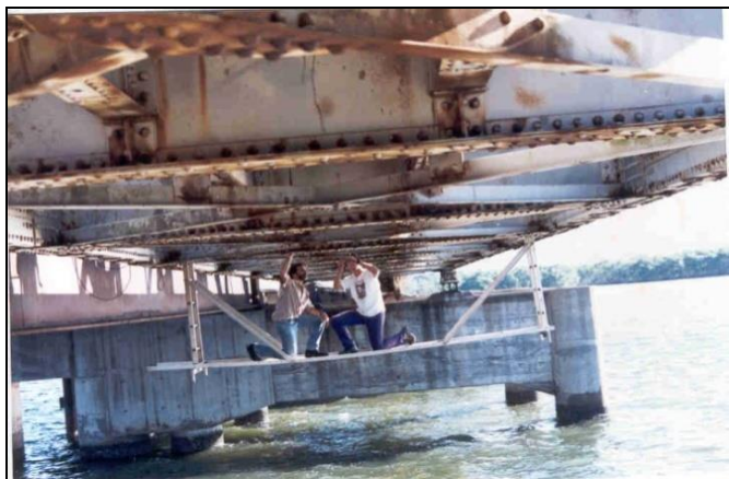
Ponte sobre o Canal dos Barreiros – São Vicente/SP
