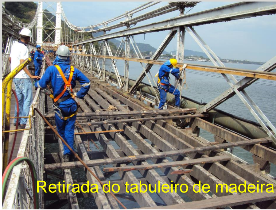
Recuperação de elemento metálicos Corroídos
