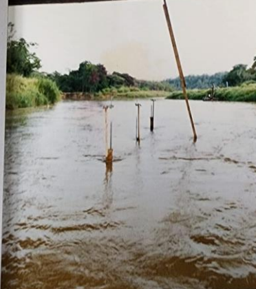
FOTO 12 - Detalhe da instrumentação para medição de flexão no meio de vão na ponte sobre o Rio do Peixe, SP 333, km 105,3.
