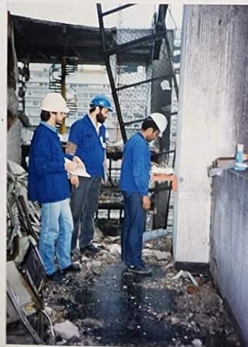
FOTO 12 - Leitura de uma das bases de clinômetro instaladas no Sede 2B.
