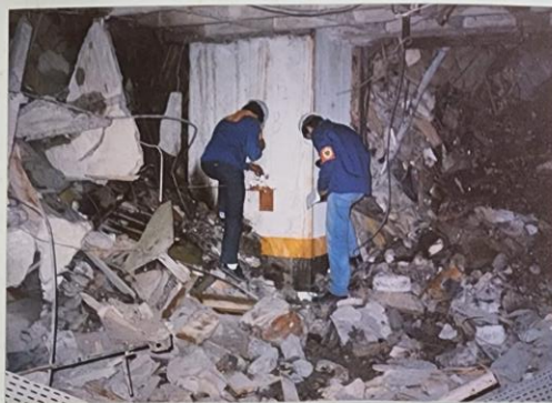
FOTO 5 - Leitura dos instrumentos instalados em um dos pilares do Sede 2B, subsolo inferior.
