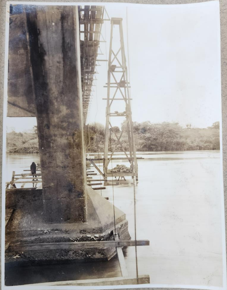
ENSAIOS DINÂMICOS - TORRE REFERÊNCIA DO MOVIMENTO TRANSVERSAL.
