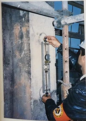
FOTO 10 - Alongâmetro - base instalada num dos pilares do Sede 2B.
