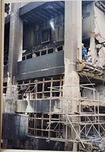
FOTO 11 - Leitura de uma das bases de clinômetro instaladas no Sede 2B.
