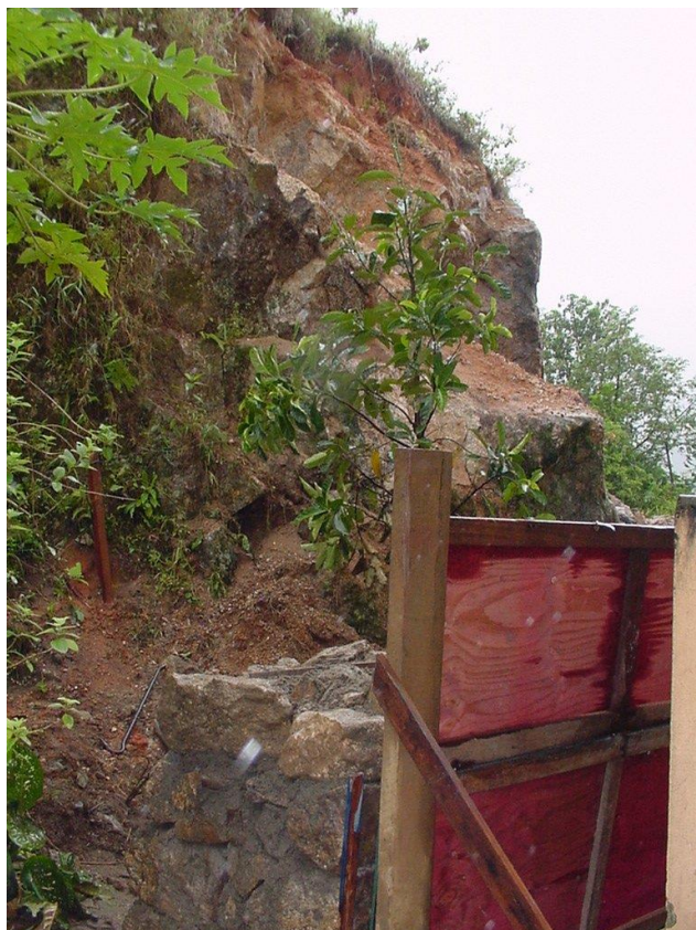
Retaludamento de talude rochosos
