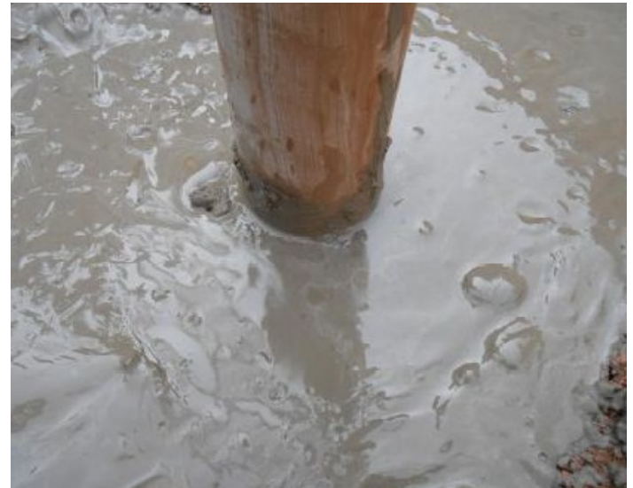
IV) Preenchimento com calda de cimento
