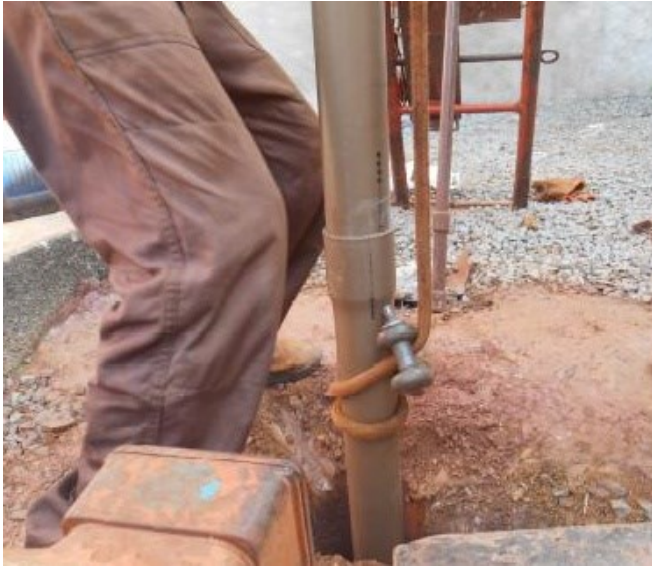
III) Instalação dos tubos de PVC
