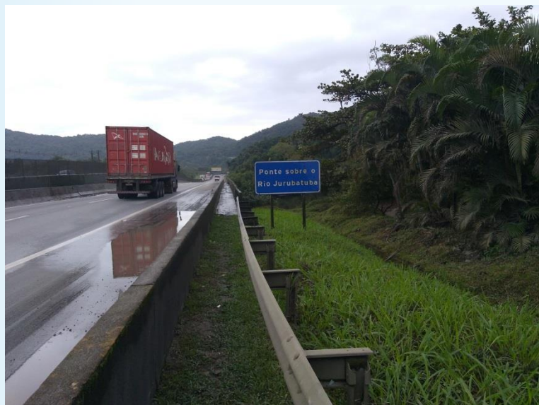
Ponte sobre o Rio Jurubatuba, vista da Rodovia Cônego Domênico Rangoni, km 253.
