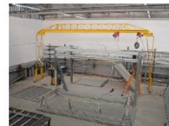
Figura 12 – Montagem da estrutural central.
