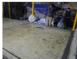
Figura 13 – Limpeza e aplicação de desmoldante no molde.
