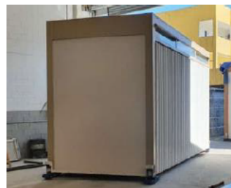
a) Módulo pré-fabricado ainda fechado – parte central em perfis de aço
