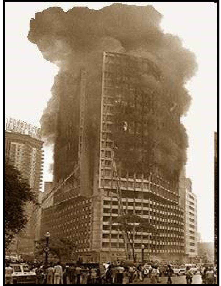
Edifício Joelma – 25 pisos – 1974
