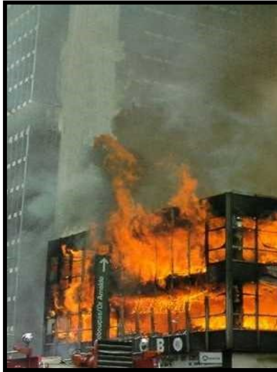
Pódio do edifício submetido a incêndio
