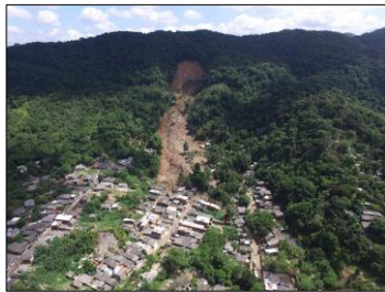
Barreira do João Guarda GUARUJÁ - SP (2020)
