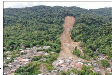
Barreira do João Guarda GUARUJÁ - SP (2020)
