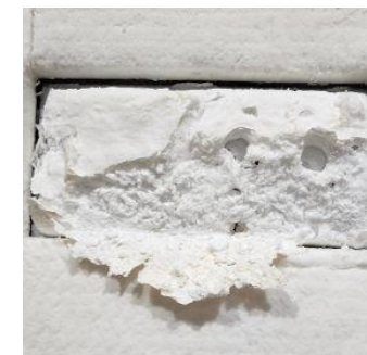
Detalhe de corpos de prova ensaiado
