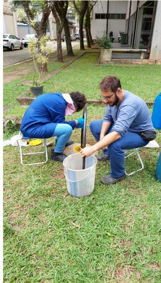
Processo de desenvolvimento dos poços para coleta de amostra de água subterrânea
