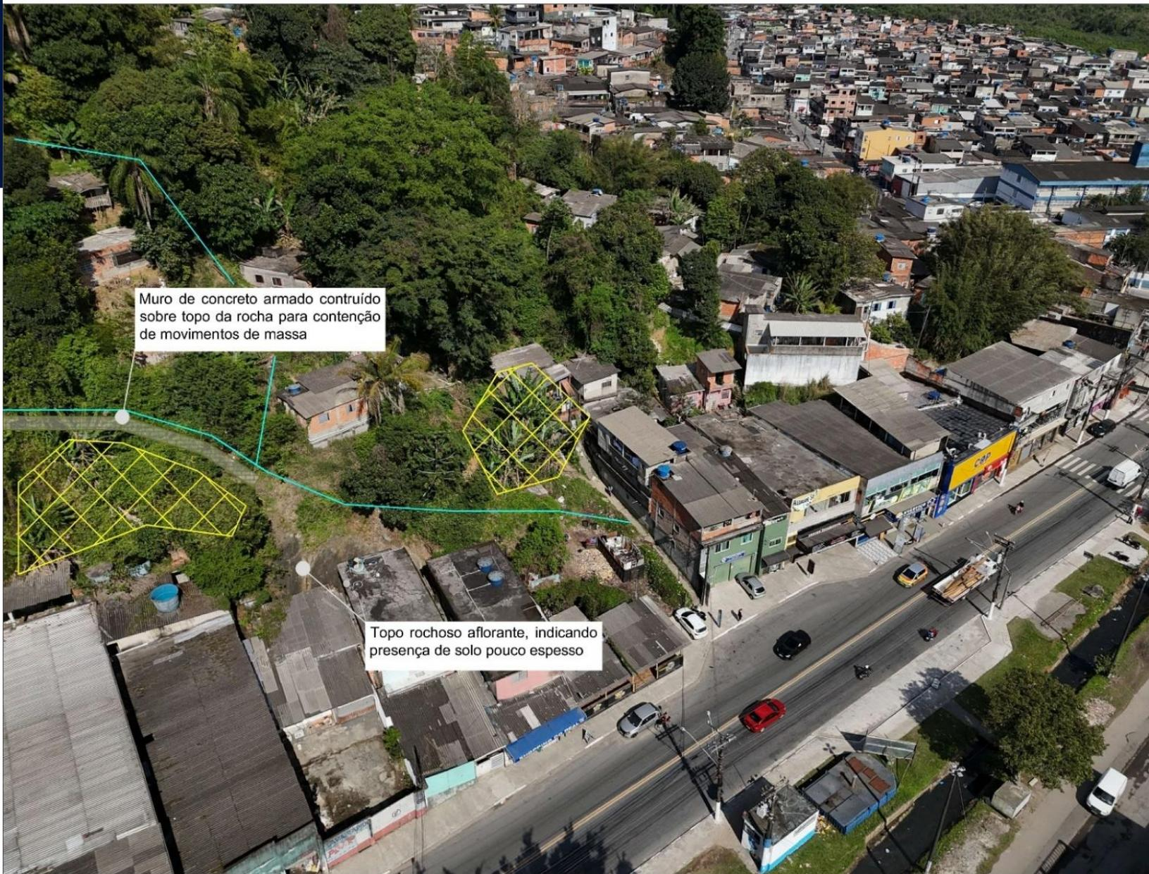
Muro de concreto armado contruído sobre topo da rocha para contenção de movimentos de massa
