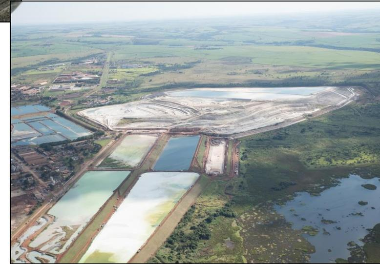
alteamento de pilhas de rejeito e verificação do seu potencial de liquefação
