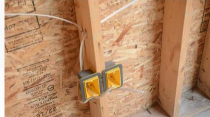
Interface parede e instalações
