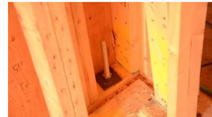
Ligação painel/piso com parafuso
