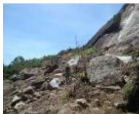
Queda de rocha ( rock fall )
