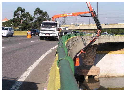
Caminhão com braço articulado e cesto – Necessidade de interdição de faixas de rolamento
