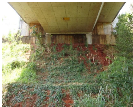
Alçapão na laje inferior da superestrutura
