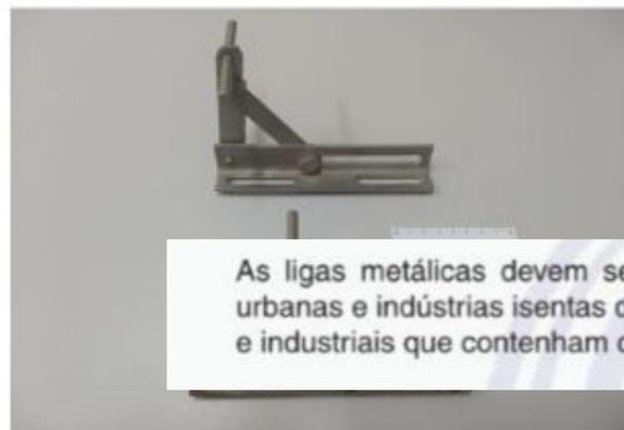
As ligas metálicas devem ser em aço inoxidável do tipo ABNT 304 (AISI 304), para atmosferas urbanas e indústrias isentas de cloretos, e ABNT 316 (AISI 316), para atmosferas urbanas, marítimas e industriais que contenham cloretos.
