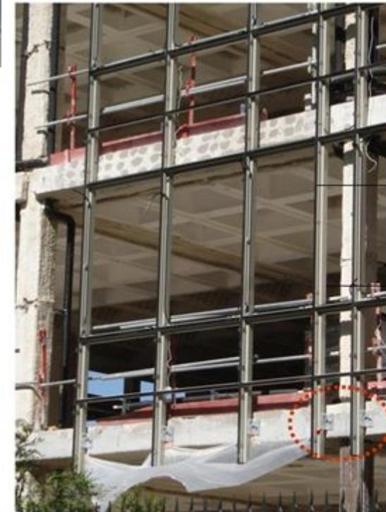
gaxeta de EPDM (interface placa de vidro e perfil metálico)
