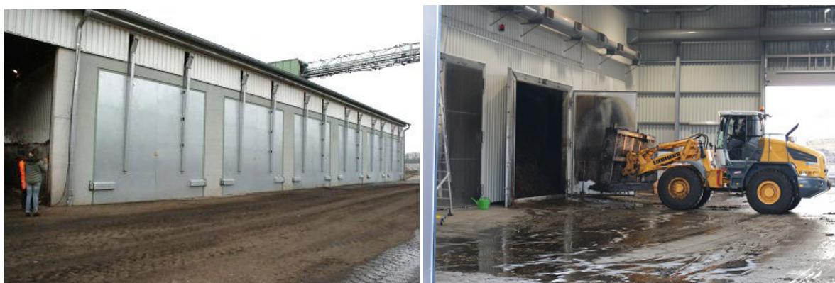
Figura 59 – Túneis de metanização do tipo “garagem” a ser implementado na modernização e ampliação da capacidade do biodigestor
